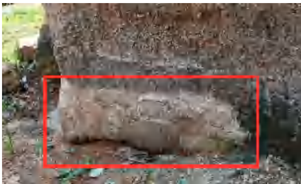
▲ 针对局部缺损、散落、侧倾的构件，可采取局部垫平、重砌的做法进行归安，侧壁、拱顶等部位失稳，可局部修复以恢复原有结构状态
