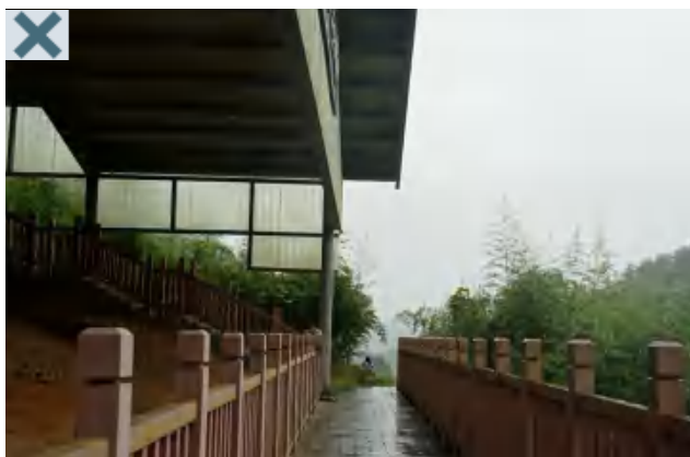
▲ 应注意侧向风雨的遮挡，避免斜风雨飘落至遗迹面
