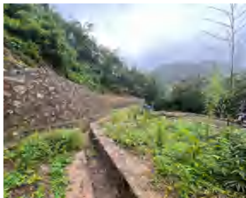
▲ 注重水害治理，做好排水、隔水等措施
