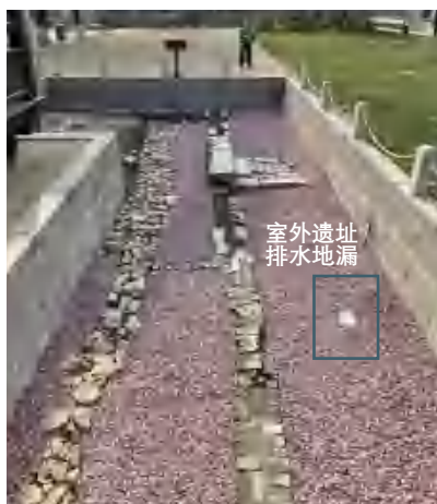
▲ 当采用集、降水井等降水措施时，应避免长期抽排水引起泥沙流失，影响遗址安全
