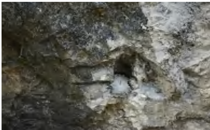
▲ 关注危岩体加固锚头隐蔽处理方式，避免灌浆材料对本体的污染
