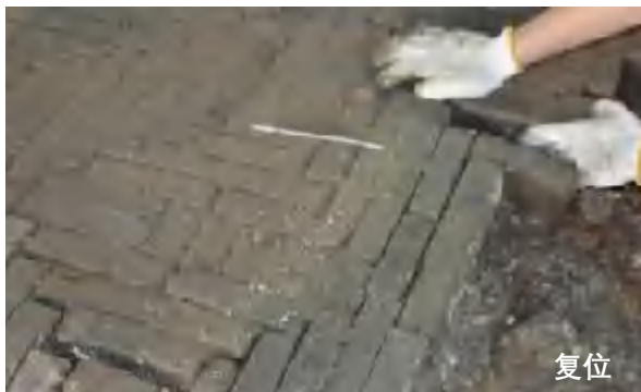
▲ 针对局部缺损、散落、侧倾的构件，可采取局部垫平、重砌的做法进行归安，侧壁、拱顶等部位失稳，可局部修复以恢复原有结构状态
