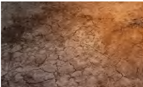
▲ 土遗址，应注意是否会出现坍塌缺损、掏蚀、沉降、开裂等结构问题
