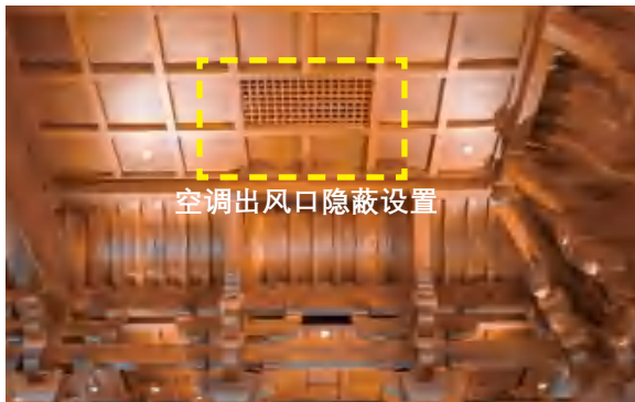
▲ 设备及管线尽量统筹设计、隐蔽设置，兼顾保护的环境控制要求、对遗址安全和风貌的影响
