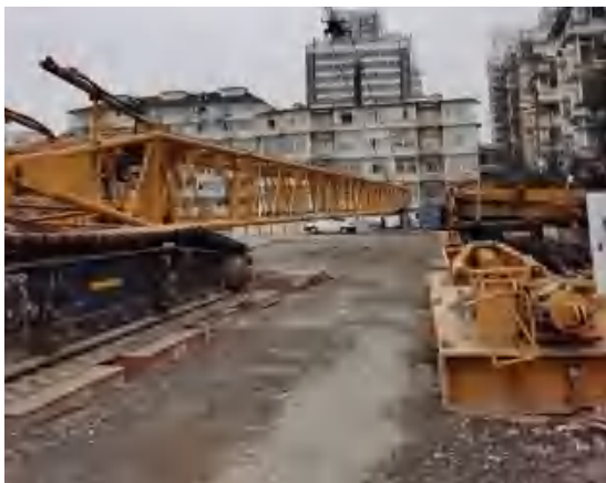
▲ 运输道路采用钢板缓解机械重量对遗址的影响
