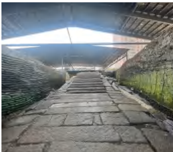
▲ 施工期间应做好遗址的防雨措施
