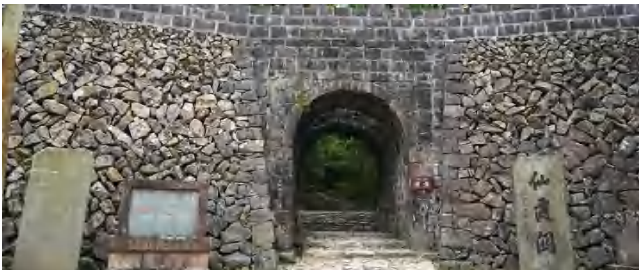
▲ 线性遗址，重点关注线路起始点、方位走向、连通方式、功能要素、节点设施等
