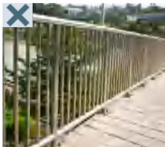
▲ 栏杆应尽量不影响展示遗址，避免大量采用如反光、亮面的金属栏杆等工业化意味重的产品
