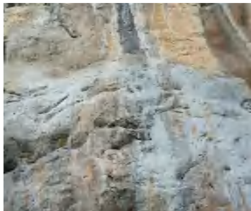
▲ 关注危岩体加固锚头隐蔽处理方式，避免灌浆材料对本体的污染
