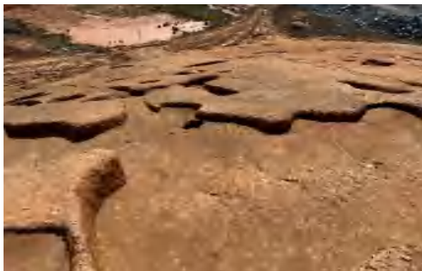
▲ 及时排除地表径流水，避免雨水冲刷及积水侵蚀遗址
