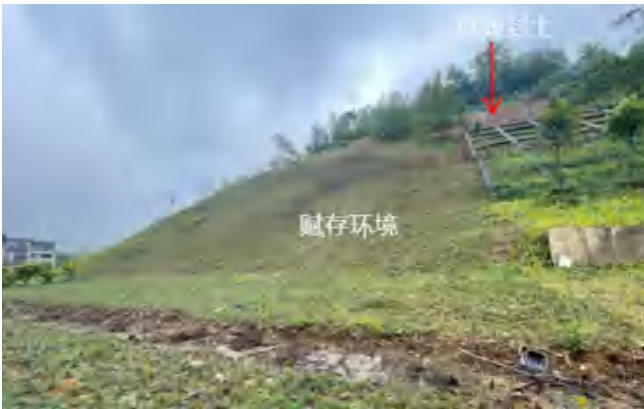
▲ 古遗址赋存环境及周边环境存在山体滑坡及水土流失风险
