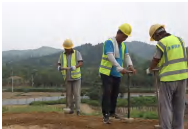
▲ 建议尽量采用人工方式进行施工，减少对本体的干扰
